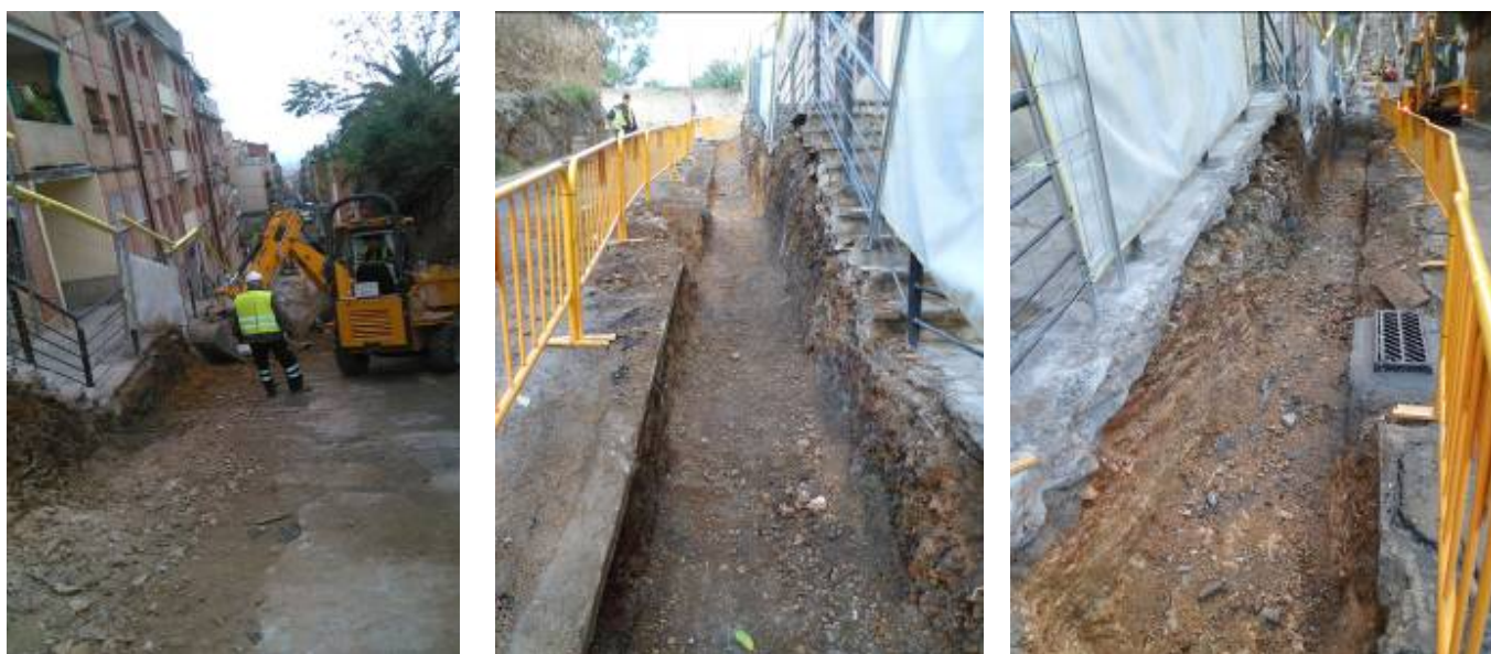
Obertura rasa encofrat escala i la seva connexió amb la REMB.200
