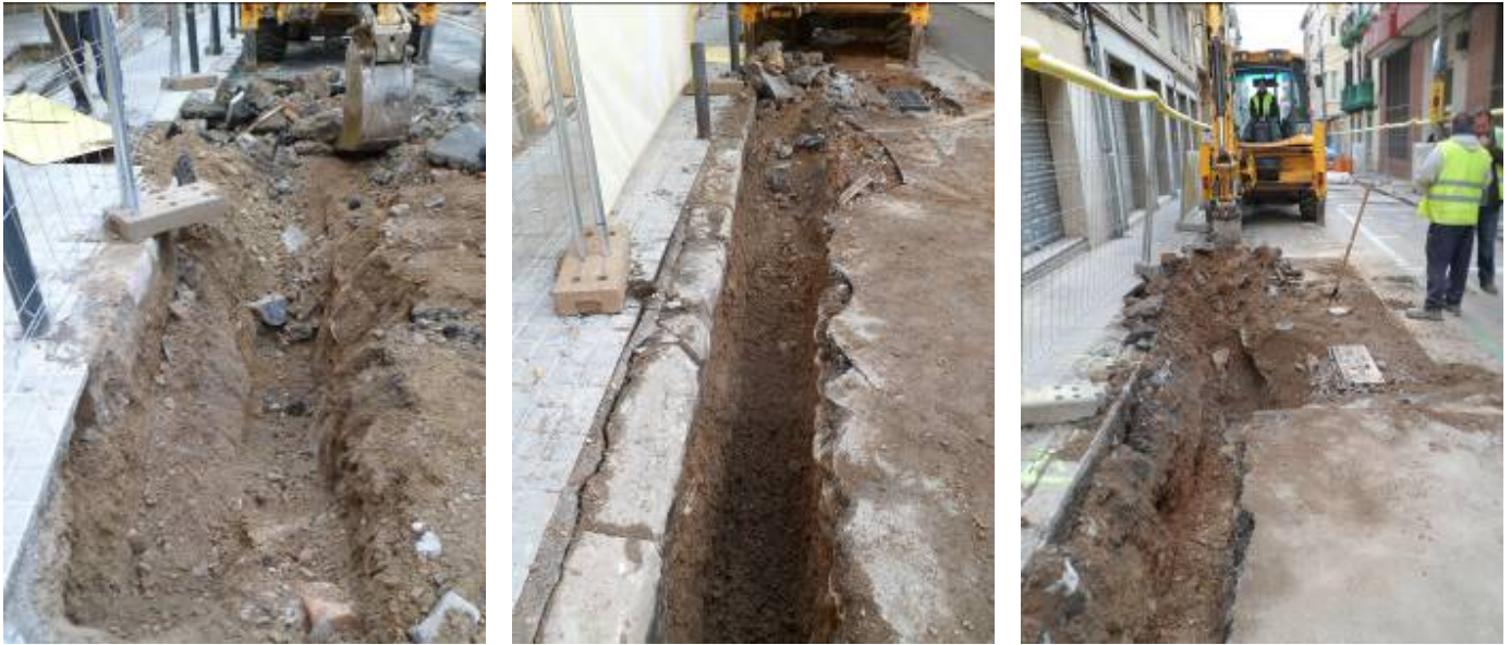
Diverses vistes del buidatge de la rasa
