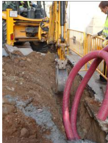
Cobertura tubs conducció instal·lació telecomunicacions –Smart City. Vista general RRSC
