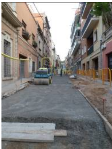
Fig.39.- SEGONA FASE: RASA CENTRAL: CAIXA.800-2
