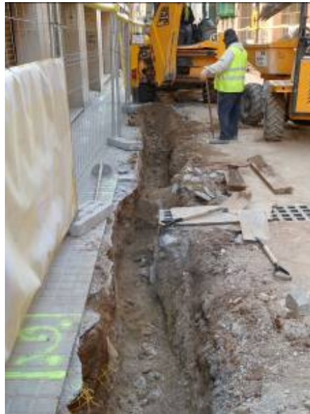
Diverses vistes del buidatge de la rasa
