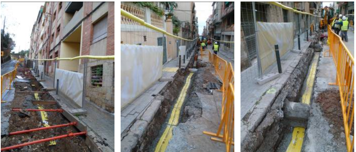
Cobertura tubs conducció instal·lació llum
