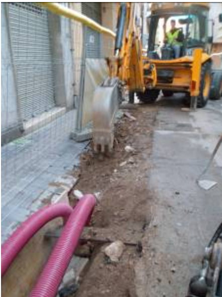
Cobertura tubs conducció instal·lació telecomunicacions –Smart City. Vista general RRSC
