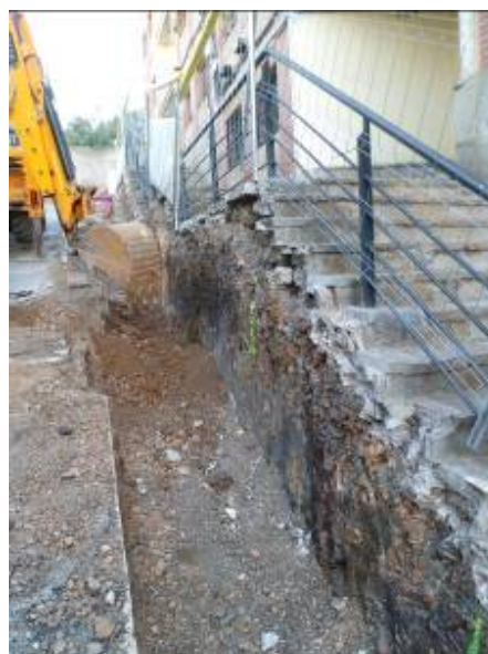
Fig.19.- PRIMERA FASE: RASA ENCOFRAT ESCALA (RRES.800)
