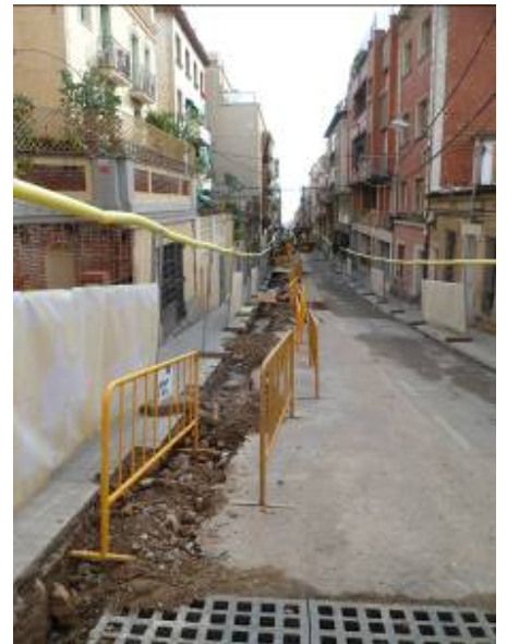
Cobertura tubs conducció instal·lació telecomunicacions –Smart City. Vista general RRSC
